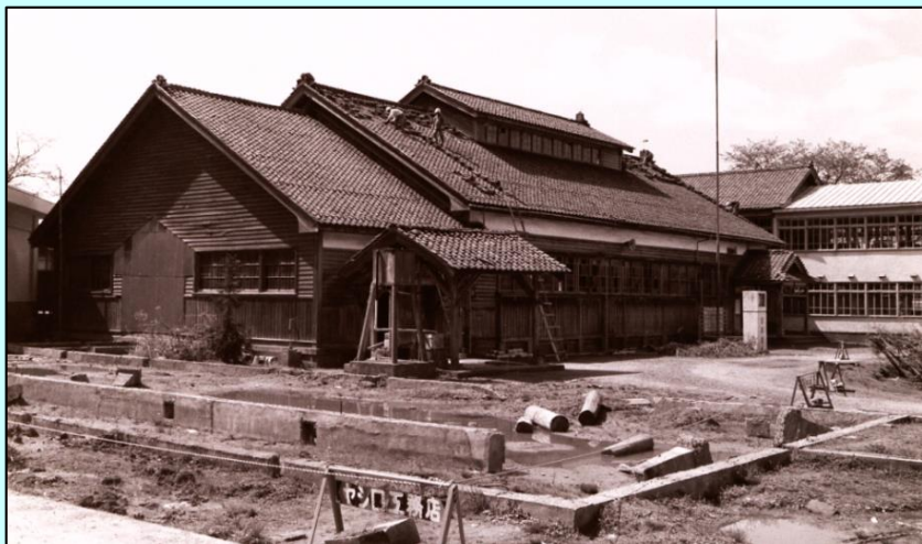
解体工事中の 旧清水東小学校体育館 (昭和50年頃)
