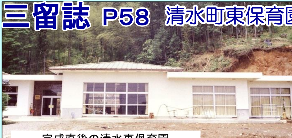
完成直後の清水東保育園
